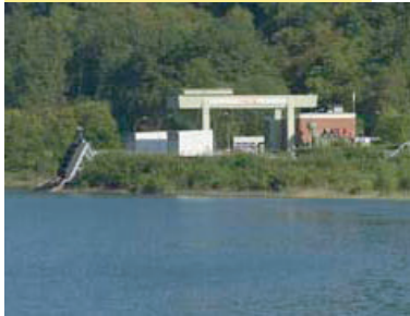
Krafthaus am Unterbecken
