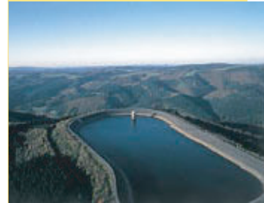
Oberbecken des Pumpspeicherwerks
