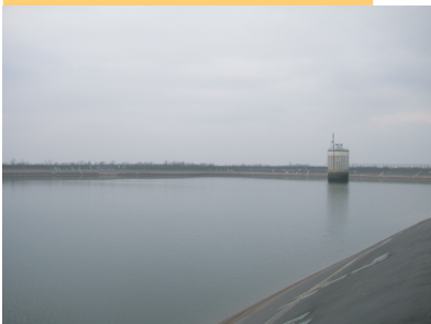
Fallturm am Nordufer
